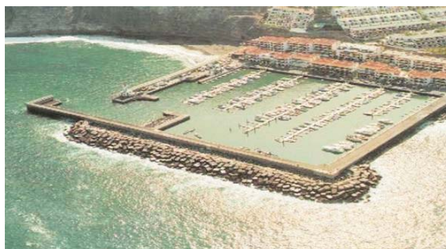
Vista panorámica del dique de abrigo de una estructura portuaria
