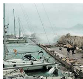
Rebase del oleaje en el dique de abrigo de un puerto deportivo
