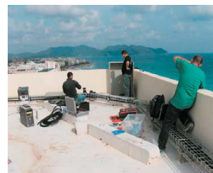
Instalación del sistema de adquisición de datos
