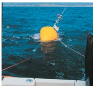
Operaciones de instalación de la Boya
