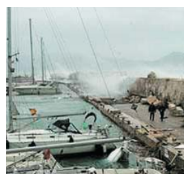
Ultrapassament de l'onatge en el dic d'abric d'un port esportiu
