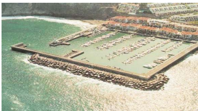
Vista panoràmica del dic d'abric d'una estructura portuària
