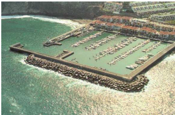
Vista panoràmica del dic d'abric d'una estructura portuària
