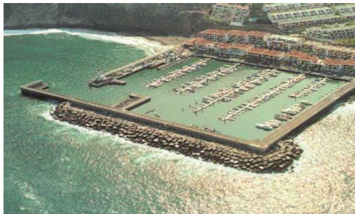
Vista panorámica del dique de abrigo de una estructura portuaria
